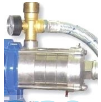
4 pav: daugiapakopio siurblio išėjimas su manometru, kurį galima pakeisti keitliu
