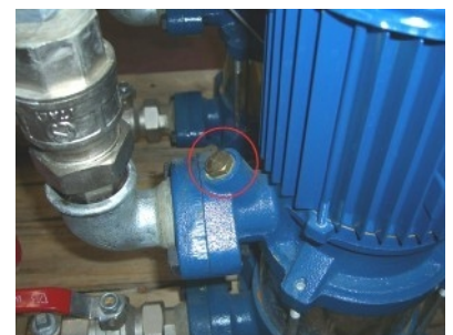
6 pav. keitlio montavimas ant siurblio padavimo linijos oro pašalinimo angos
