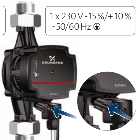
21. pav. Signalų kabelio prijungimas prie ALPHA1 L siurblio
