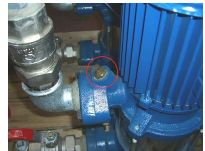
7 pav.: jutiklio montavimas prie siurblio oro išleidimo angos
